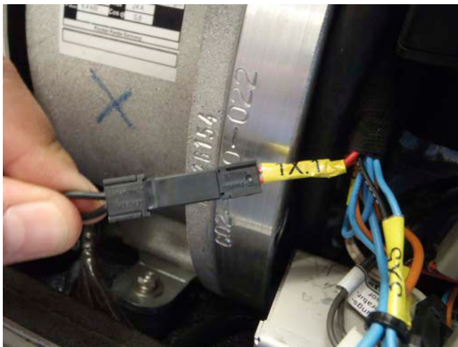
Fig. 15.5-1: Not Stop Brücke im Kabelbaum
