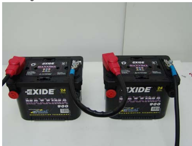
Fig. 5.10.3.1-4: Installation Starterbatterie 24V
