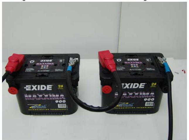
Fig. 5.8.4.1-4: Installation batterie de démarrage de 24V
