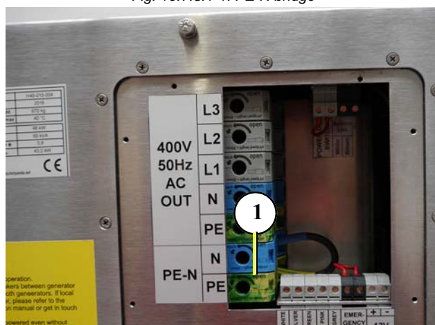
Fig. 10.7.3.1-1: PE-N bridge
