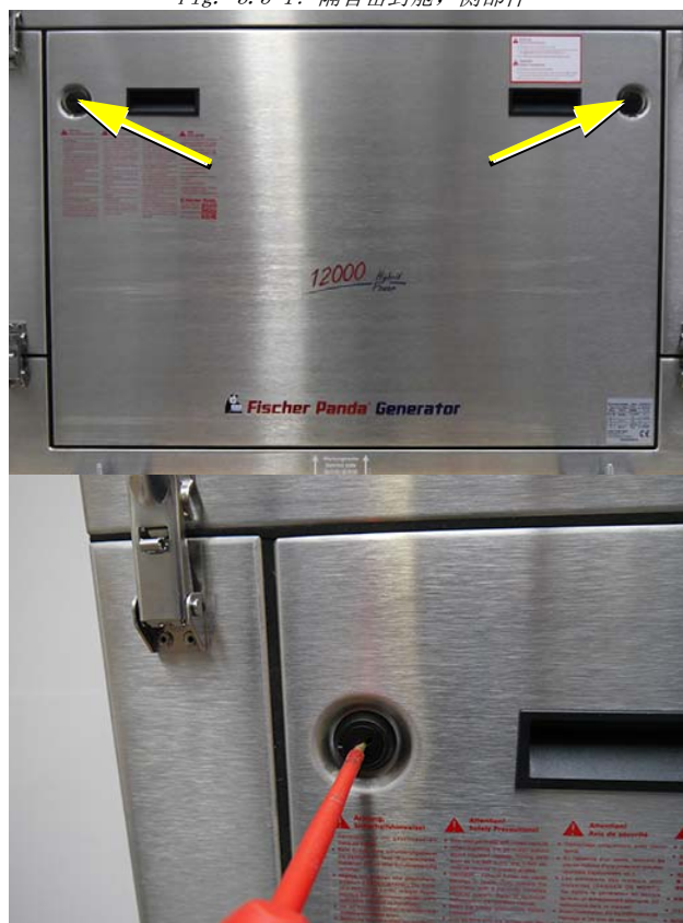
Fig. 3.5-1: 隔音密封舱，侧部件
