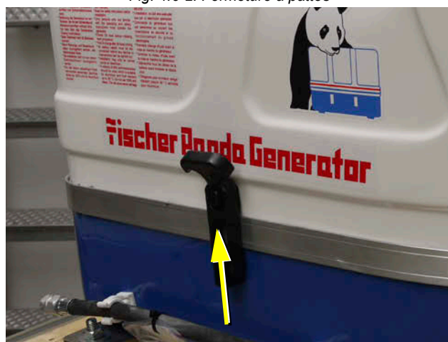
Fig. 4.6-2: Fermeture à pattes
